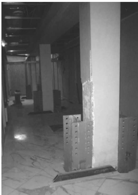
Figura. 8 - Tratti di montanti verticali a piano primo durante la messa in opera
