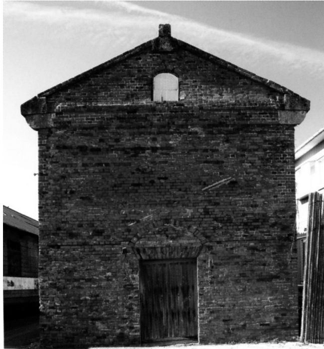
Fig.12 (derecha) Puerto de Oma (Sado, Prefectura de Niigata). Construcciones en ladrillo, estilo inglés, final del siglo XIX, periodo Meiji (fuente: Nishiyama H., 2013, Sado Mine, p. 67)
