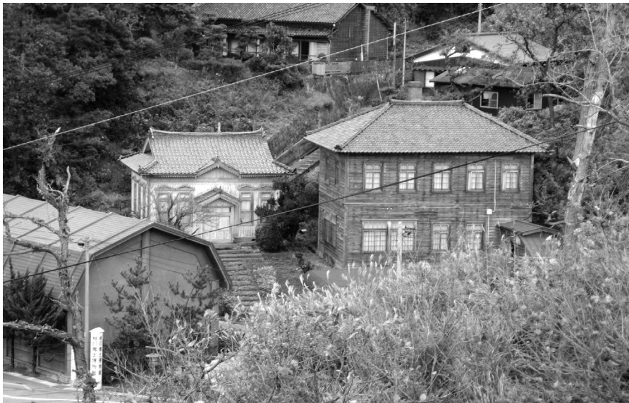
Fig. 9 y 10. Aikawa (Sado, Prefectura de Niigata). El centro de la ciudad con construcciones en estilo inglés, final del siglo XIX, periodo Meiji (fuente: © O.Niglio)
