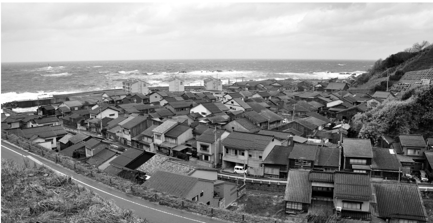
Fig.6. Aikawa (Sado, Prefectura de Niigata). El pueblo de los mineros. (fuente: © O.Niglio)
