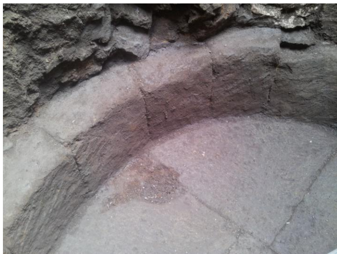
Fig. 14. Particolare del filare di base della cisterna.
