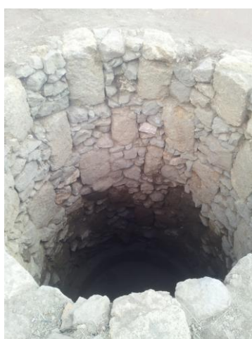
Fig. 13. Rivestimento della cisterna in opera a scacchiera.
