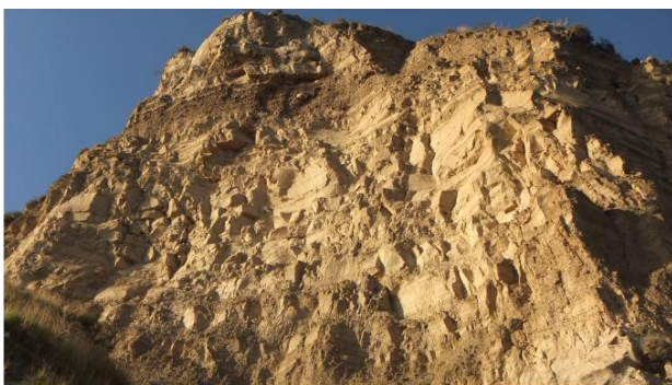
Fig. 13 - Miliscola settore orientale, in cui si notano la parete a strapiombo, l'intensa fratturazione, e la grande quantità di blocchi instabili.
