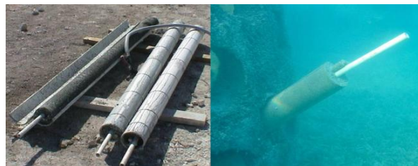
Figura 10 Ancoraggio con pali battuti (Fonte: www.reefball.org )
