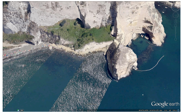
Fig. 18 - Falesia di Coroglio, ulteriore arretramento a causa dell'erosione marittima anno, 2015.
