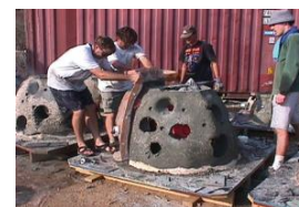
Figura 6 Scasseratura modulo Reef Ball (Fonte: www.reefball.org )
