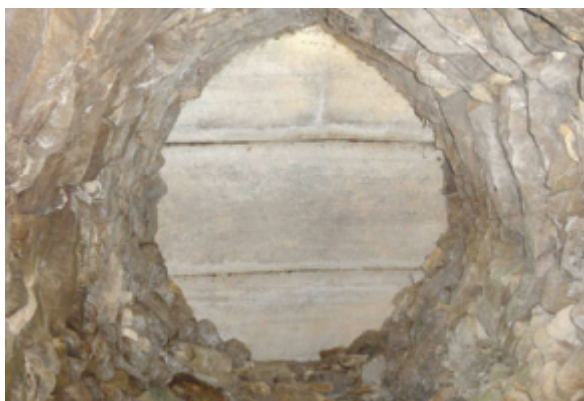
Fig. 8 - Particolare della volta encorbellee bucata, coperta a seguito dei restauri con una lastra di cemento; è probabile che in origine, a chiusura della bocca della volta, ci fosse una pietra di grandi dimensioni.
