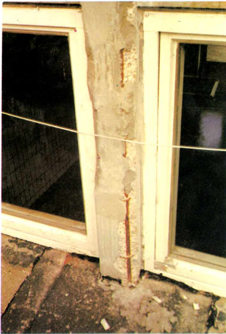
Foto 12 - Struttura ammalorata sotto le crepine dello spalling
