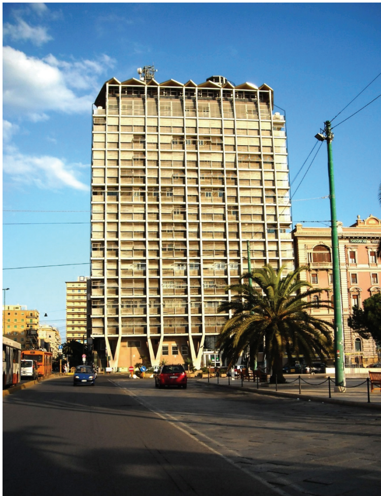
Cagliari Palazzo Enel, sede regionale dell'omonima azienda 62 , lato prospettante su via Roma (foto di Cristiano Cani [112]).
