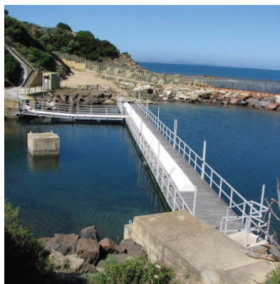
Punta Tramontana (Castelsardo-SS): sul pontile, anodo degli elettrodotti SACOI (Sardegna CORSICA Italia) e SAPEI (Sardegna PENisola Italiana) entrambi in corrente continua. Il primo da 200 kV e 300 MW, il secondo da 500 kV e 1000 MW. – Vedi Figura 3. (foto M. De Vincenzi).
