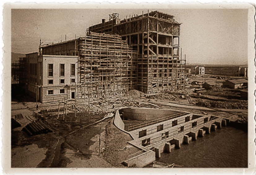
Figura 8 – Lavori in corso per la realizzazione della centrale termoelettrica di Santa Caterina, entrata in funzione nel 1939, alimentata a carbone del Sulcis. Foto da [138].
