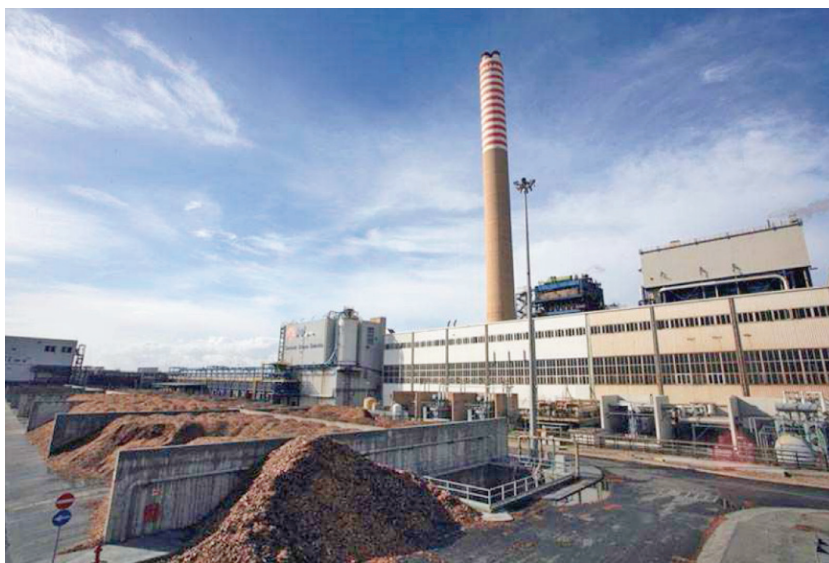
Centrale termoelettrica Grazia Deledda-Sulcis. A partire dal 2006 questa centrale ha iniziato a utilizzare biomasse vegetali in co-combustione. Ciò consente, in un bilancio complessivo, una sensibile riduzione delle emissioni di CO 2 . Nella foto, in primo piano, il deposito delle biomasse. [14]
