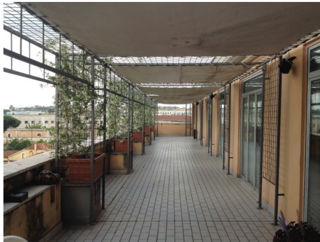
Terrazza al 5° piano lato sud-est della Palazzina A
