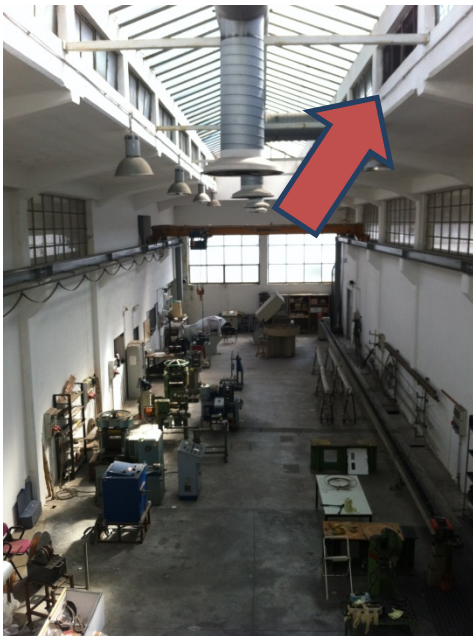
Figura 5 - Campata centrale edificio C
