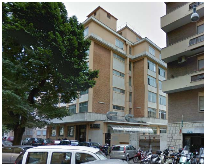
Ingresso principale su via dei Taurini (Palazzina A)
