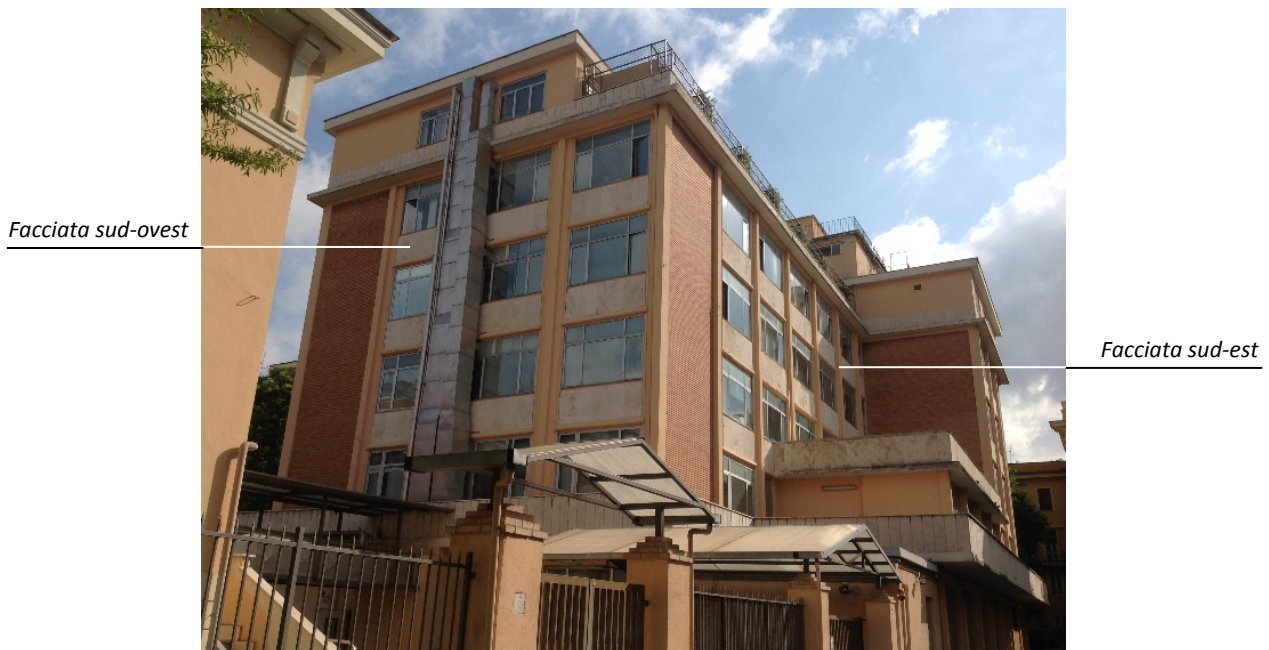
Facciate sud-ovest e sud-est della Palazzina A
