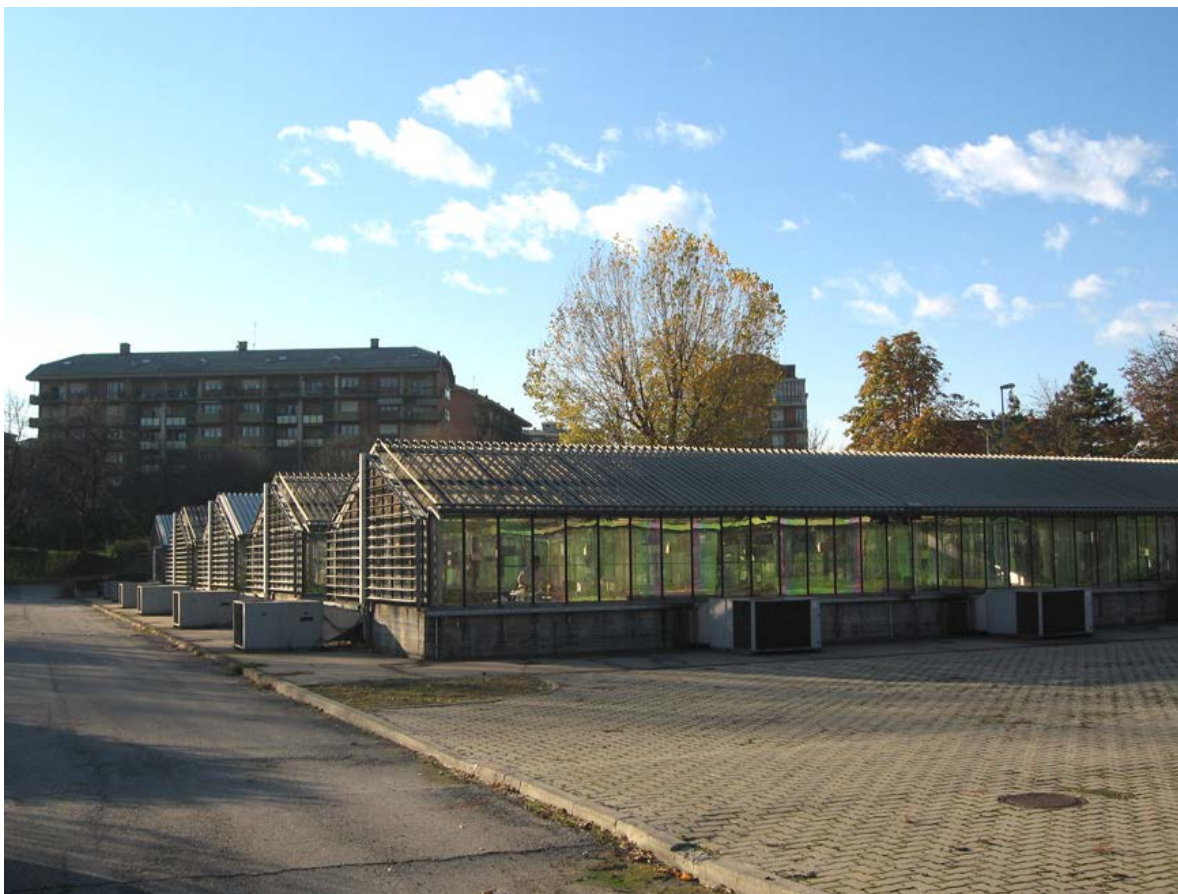
Serre dell'IVV da ristrutturare
