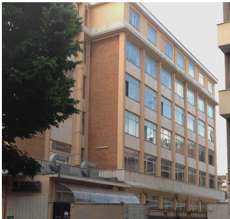
Facciata nord della Palazzina A
