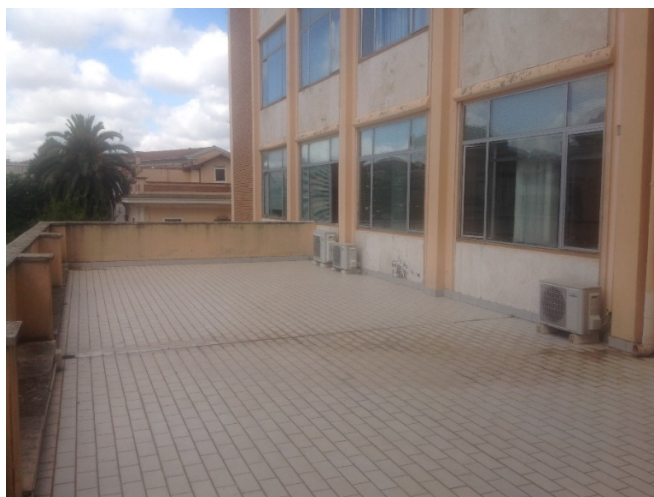
Terrazza al 2° piano lato sud-est della palazzina A
