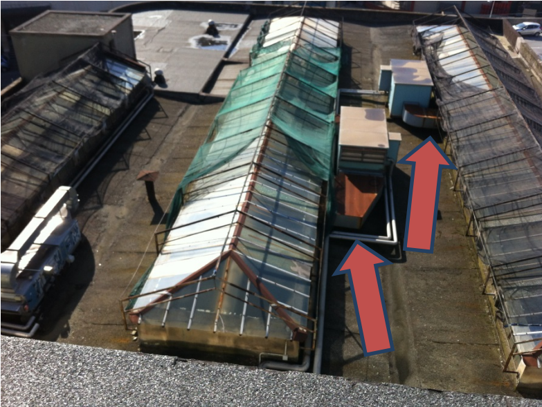
Figura 6 - Tetto capannone (UTA al centro e sulla destra)
