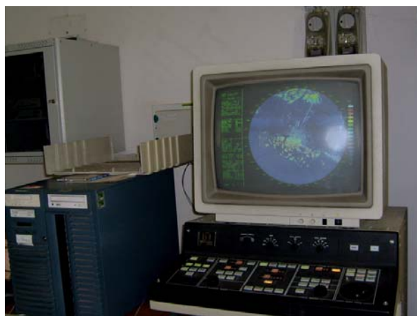
Figura 2 – Consolle per il controllo locale del radar.
