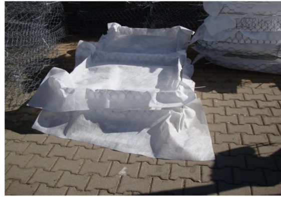
Figura 2 – Fasi di confezionamento dei materassi.
