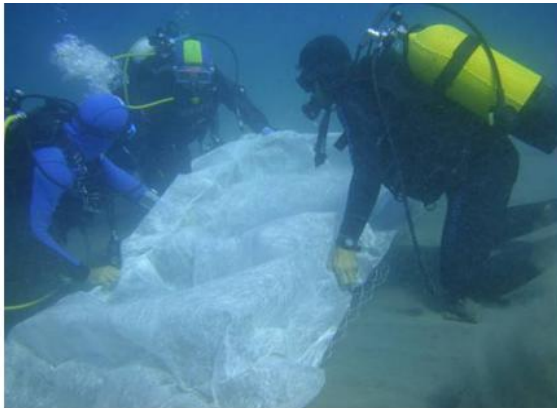
Figura 3 - Posizionamento subacqueo dei materassi rivestiti di tessuto Terram 1000 (a sinistra) e riempimento dei materassi con sorbona ad aria (a destra).
