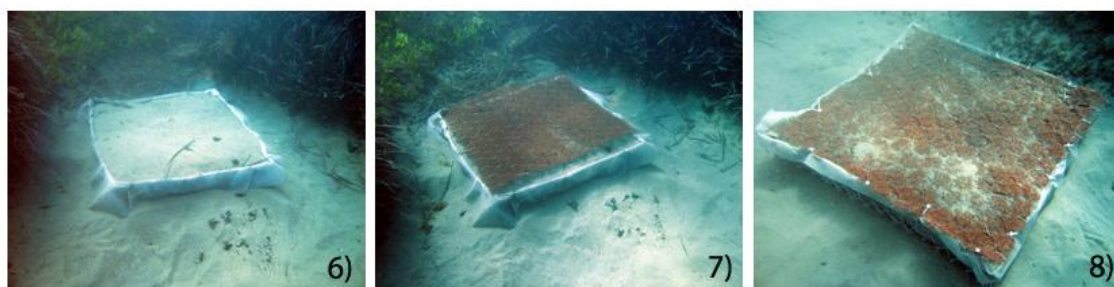
Figure 6-8 - Materasso collocato sul fondo e riempito di sabbia (6), materasso coperto con geostuoia (7), materasso con geostuoia fissato lungo il bordo con fascette di nylon (8).
