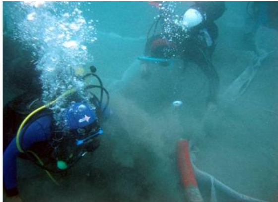
Figura 3 - Posizionamento subacqueo dei materassi rivestiti di tessuto Terram 1000 (a sinistra) e riempimento dei materassi con sorbona ad aria (a destra).
