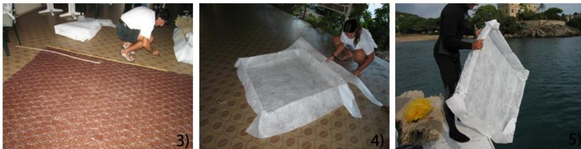
Figure 3-5 - Rivestimento del materasso rivegetabile in rete metallica con geotessuto (3), geostuoia in fase di sezionamento (4), materasso rivegetabile pronto per la messa in mare (5).
