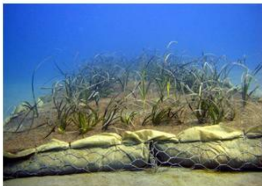
Figura 4 - Varie fasi della piantumazione su materassi.
