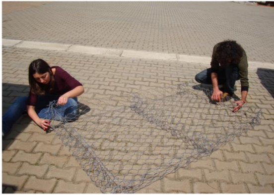
Figura 2 – Fasi di confezionamento dei materassi.
