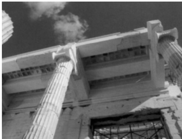
Fig. 11 - Il soffitto "restaurato" dell'ala ovest della sala centrale dei Propilei (2009). La quantità di elementi nuovi è massima. Foto T. Tanoulas.
