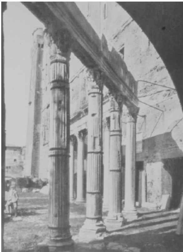
Fig. 2 - Consolidamento con cerchiature e stabilizzatori metallici del portico degli Dei Consenti a Roma (Luigi Canina, metà del XIX sec.).
