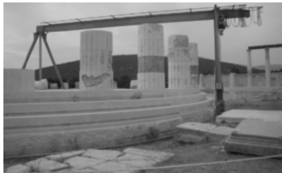
Fig. 16 - Tholos di Epidauro. Ricostruzione completa della base e delle strutture in elevazione dal nulla (foto Tampone, 2009); vandalismo su minuscoli frammenti antichi che sono stati inglobati nella massa di nuovo marmo lavorato a macchina e rifinito a mano per simulare l'antico. Notare il carro ponte per la posa dei blocchi.
