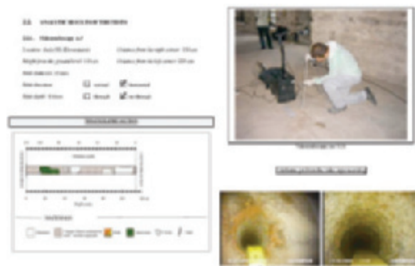
Fig. 7 - Esecuzione di una videoendoscopia nelle volte che sostengono i matronei.
