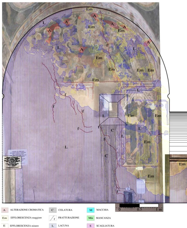
Figura 9. La Cripta di San Francesco d'Assisi in Irsina - Parete Nord - Mappatura del degrado su immagine orto rettificata
