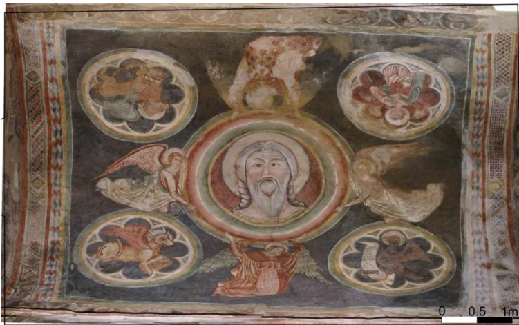
Figura 8. La Cripta di San Francesco d'Assisi in Irsina - La Volta - Rilievo architettonico e immagine orto rettificata
