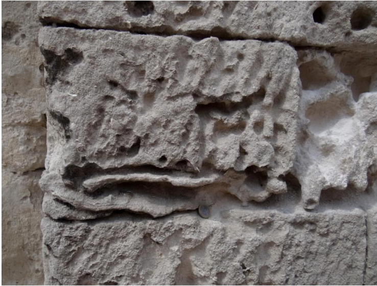
Figura 4. Matera: Chiesa di San Francesco. Fenomeni di alveolizzazione sulla parete esposta verso sud-ovest
