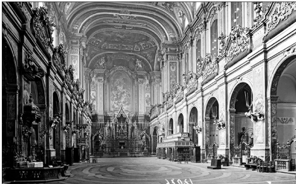
Fig. 9 – Interior view of the church of Santa Chiara in Naples before 1943 (Soprintendenza per i Beni architettonici, paesaggistici, storici, artistici ed etnoantropologici per Napoli e la provincia).
