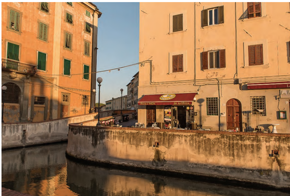
Figura 21 - Fra Viale Caprera e Piazza del Luogo Pio: tratto del canale, di fronte ai Bottini dell'Olio, interrito alla fine dell'Ottocento, portato recentemente alla luce
