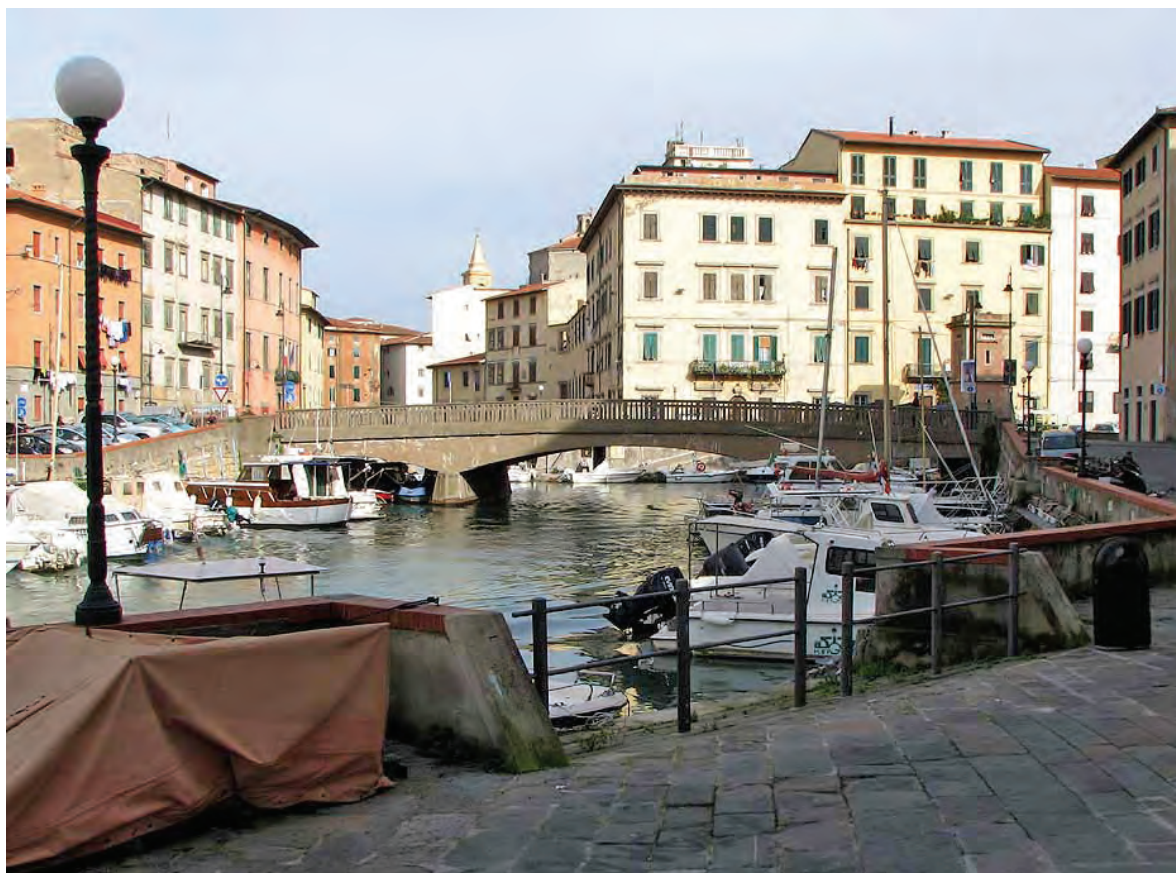
Figura 26 - Ponte di via della Venezia visto dagli Scali delle Ancore, che unisce questi agli Scali di Rosciano
