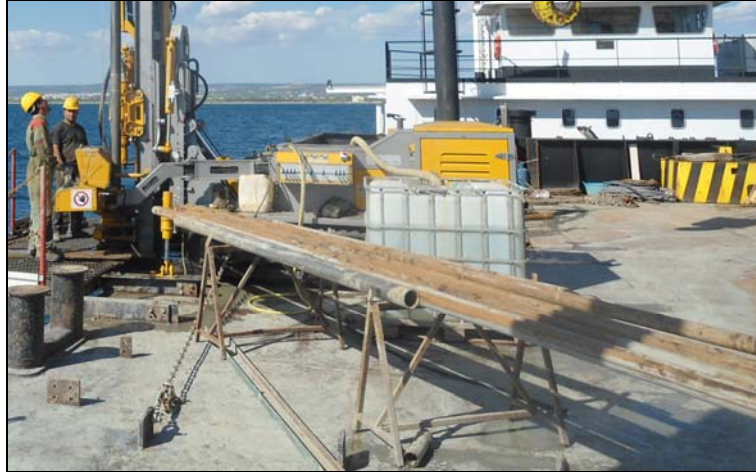
Foto 1 –Particolare delle aste di perforazione utilizzate.
