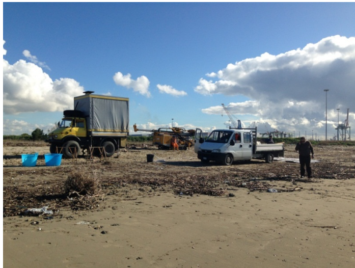
Cantiere installato in corrispondenza del sondaggio PP00 sulla spiaggia "Lido Azzurro"
