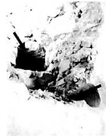
80. Mercato S. Severino. Interno del Cisternone, condotte di deflusso lungo la parete W. Le frecce indicano la direzione del deflusso d'acqua dall'invaso.
