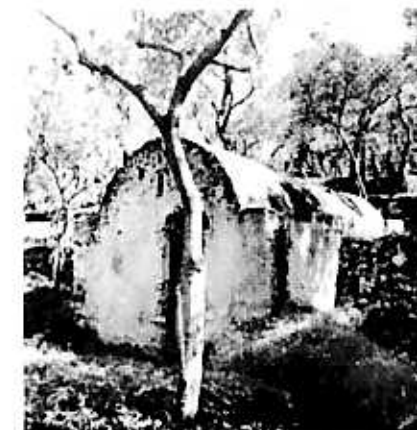
62. Anacapri. Ricovero e deposito in un uliveto (da Pane 1965).
