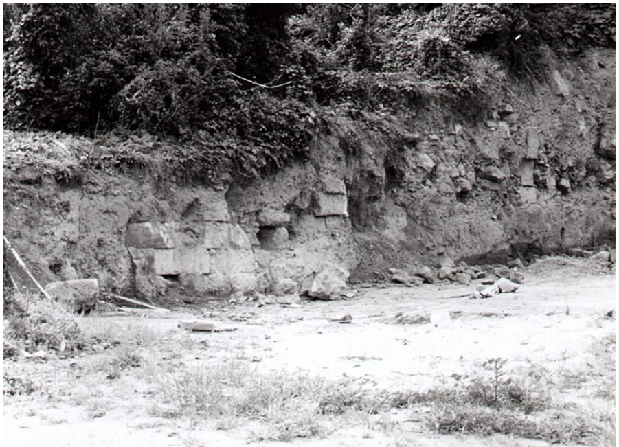
Fig. 13. Particolare dei resti delle opere murarie al confine tra le ex proprietà Pisano e Randazzo (foto M Archivio Università di Catania).
