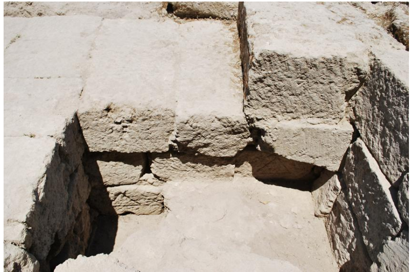
Fig. 7. Blocchi di fondazione della torre/bastione con segni di cava (foto Archivio Università di Catania).
