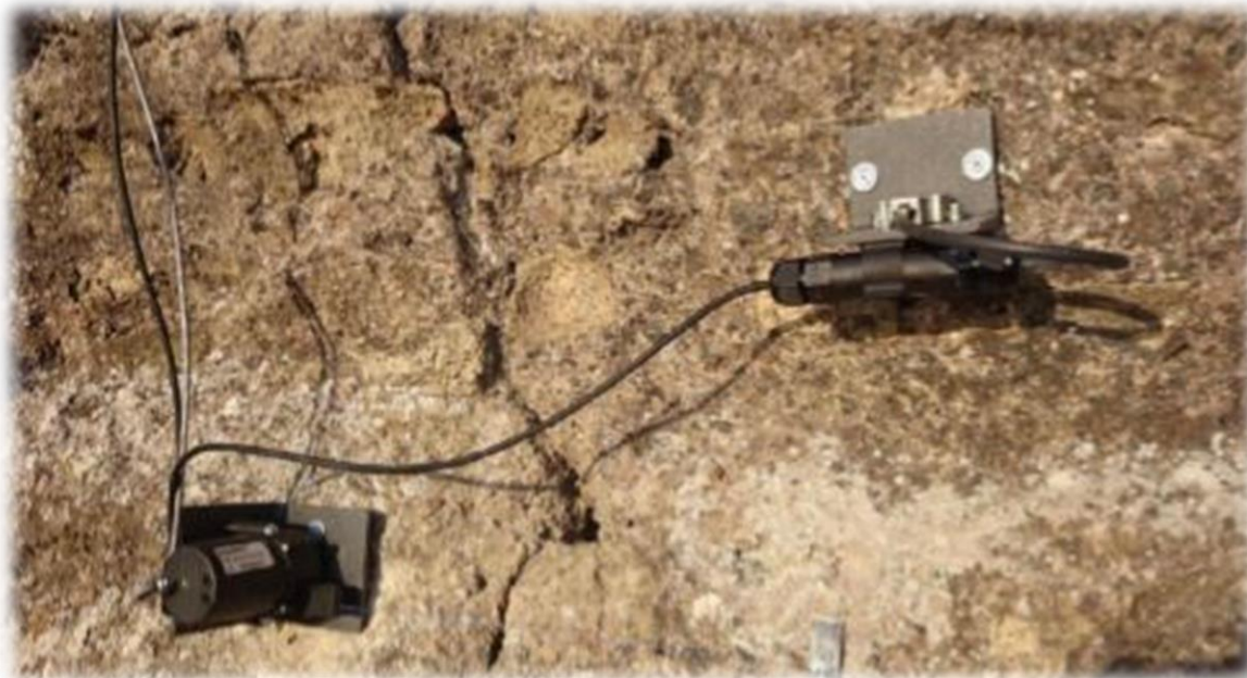
Tiltmetro e estensimetro: tali sensori monitorano lo stato della crepa (estensimetro) e lo scivolamento (tiltmetro) del muro a destra della crepa a seguito dell'eventuale ulteriore apertura della stessa
