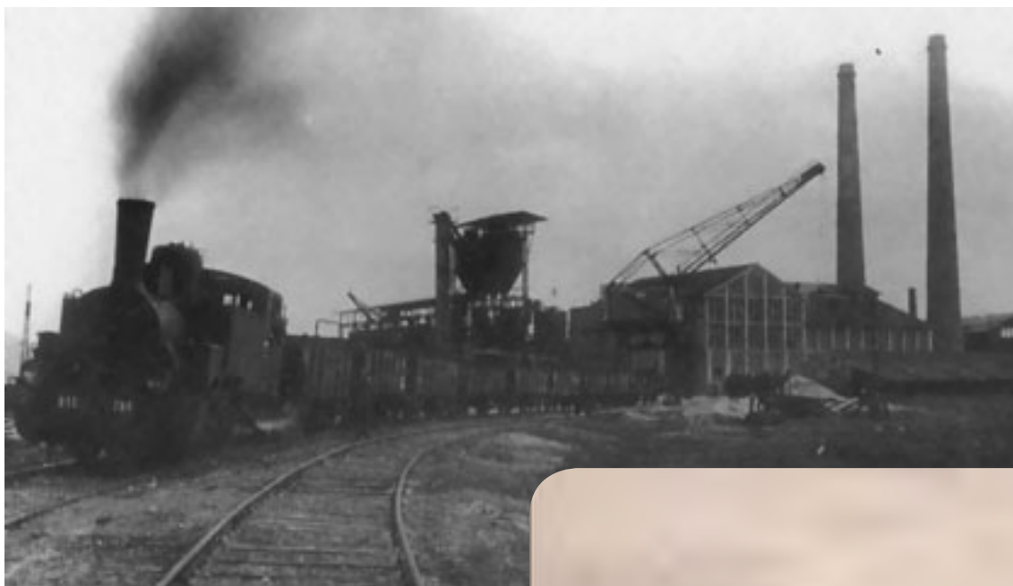
Fig. 1 Treno a Vapore che collegava la stazione di Torre del Lago con le zone di estrazione della sabbia e della torba
