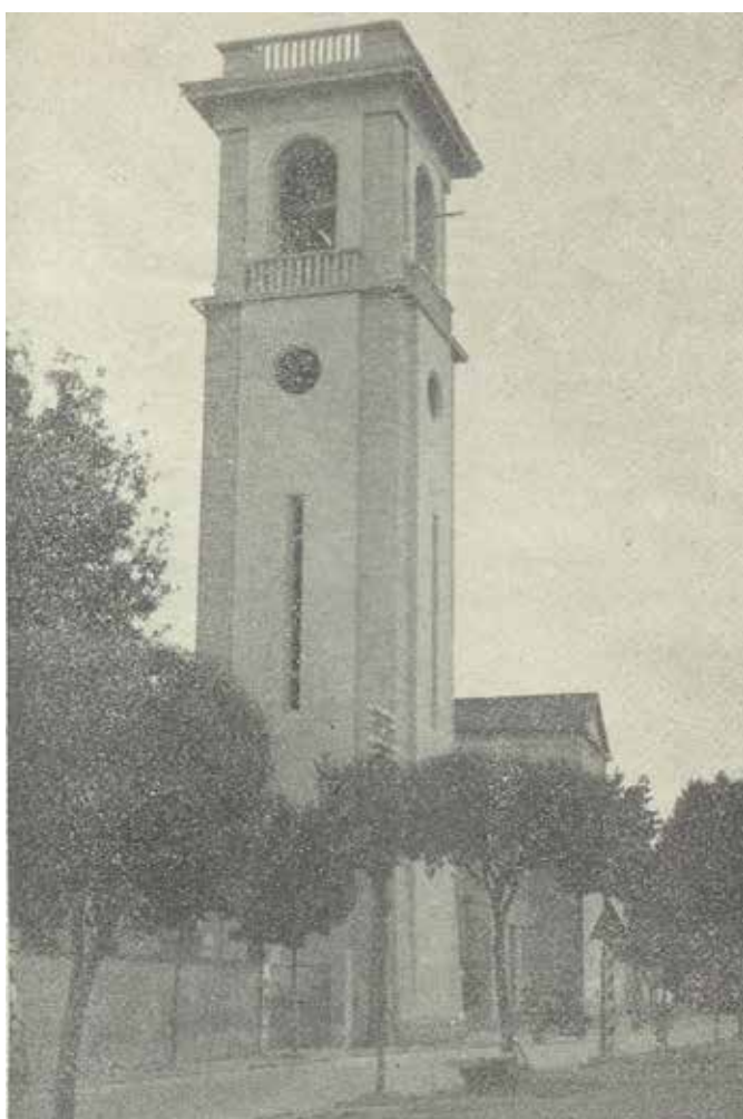
Fig. 5 Il nuovo campanile della chiesa di Torre del Lago.
