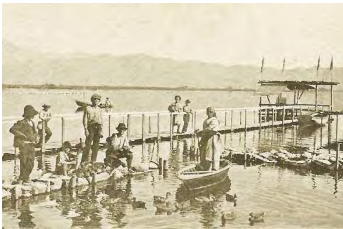
Fig. 4 Sponda di Torre del Lago: pontile per l'attracco delle barche.
