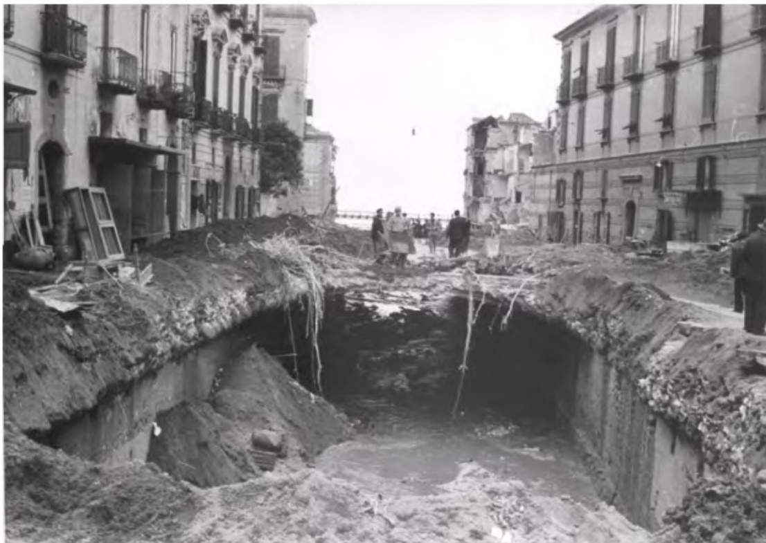
Figura 19 - Maiori. Effetti dell'alluvione del 1954 alla foce del Torrente Regina Major (Foto del Servizio Idrografico e Mareografico di Napoli, 1954).
