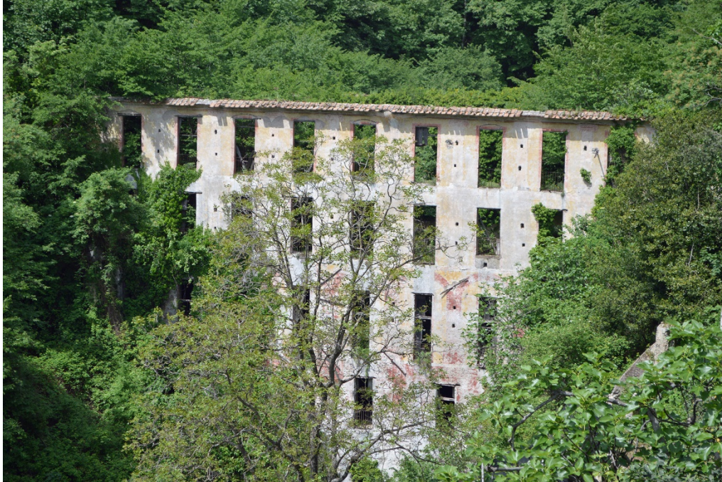
Figura 6. Valle delle Ferriere. Resti di un edificio adibito a cartiera.
