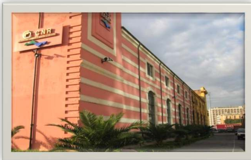
Figura 5 – Sede ISMAR-NA: Esterno
