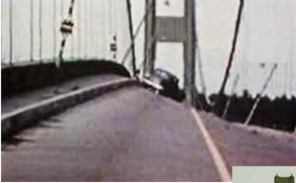
Figura 1.12 – Foto delle fasi del disastro di Tacoma: In alto l'inizio delle oscillazioni del ponte; a destra il crollo del ponte.
