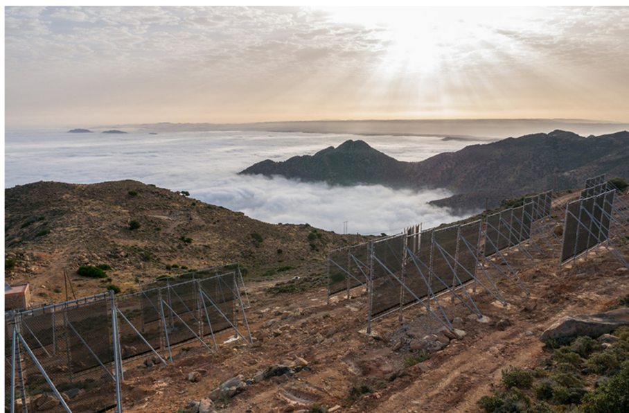
Figura 7.50 – Collettori di nebbia, sulle alture del monte Boutmezguida, nell’Anti Atlante marocchino pronti a trasformare in acqua liquida il “mare” di nebbia che hanno davanti [1043].
