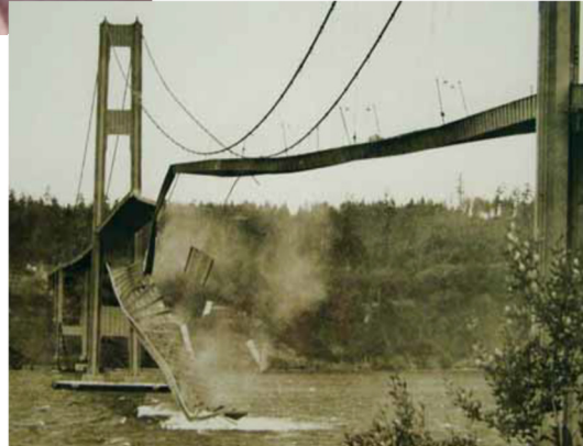
Figura 1.12 – Foto delle fasi del disastro di Tacoma: In alto l'inizio delle oscillazioni del ponte; a destra il crollo del ponte.
