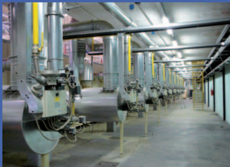
Bruciatori (sopra) e recuperatori termici (sotto)
