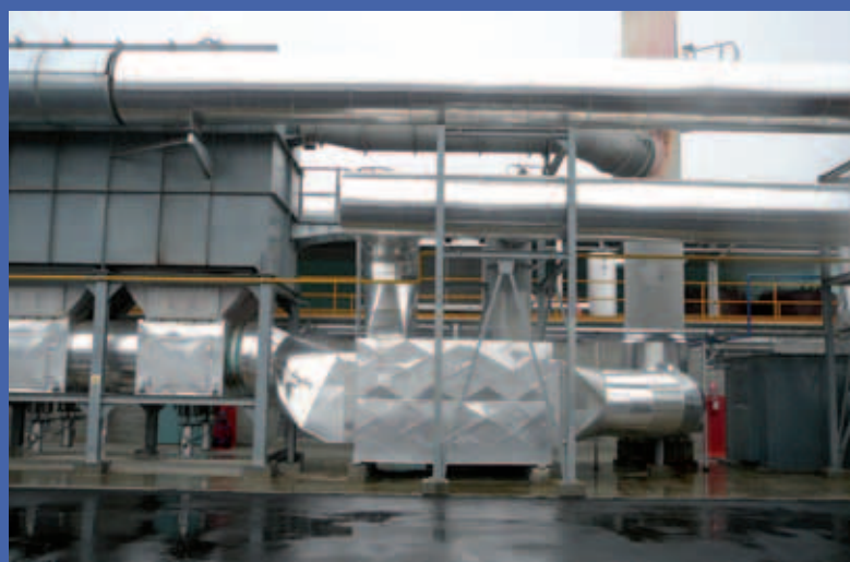
Bruciatori (sopra) e recuperatori termici (sotto)
