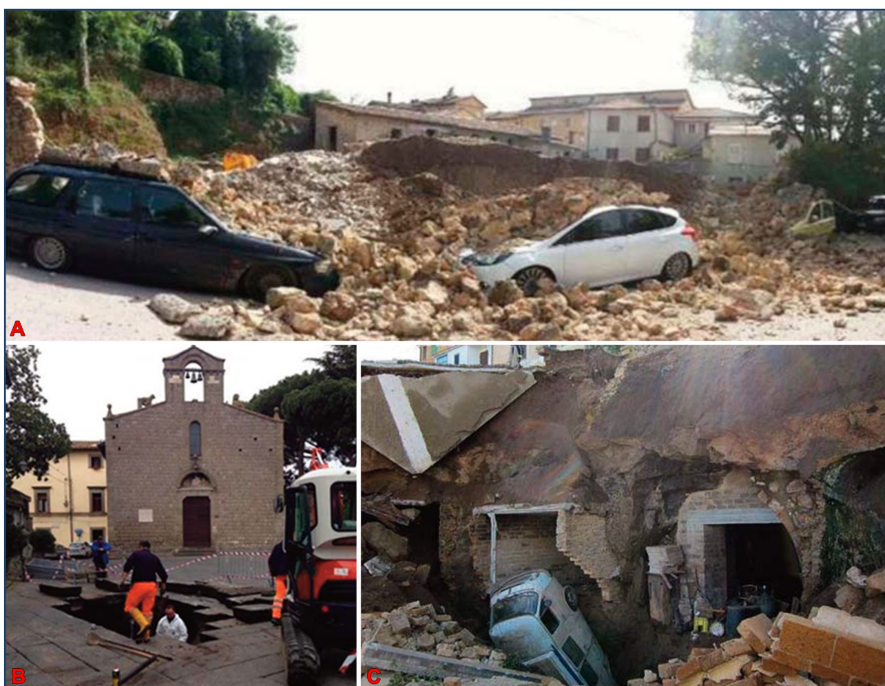
Fig. 1: Esempi di sinkholes antropogenici: A) Rieti, collasso di un tratto delle mura in Via della Cavatella (2014); B) Viterbo, voragine in Piazza del Gesù (2012); C) Viterbo, crollo di cantine (2012).
