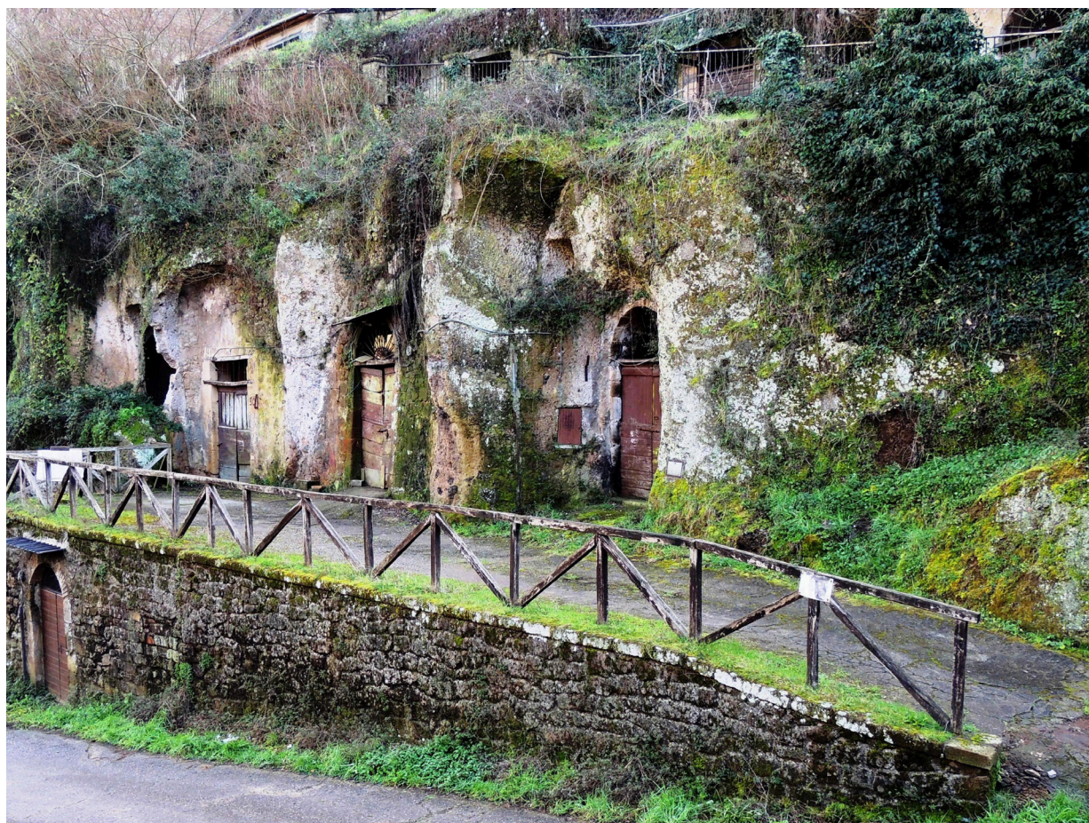
Fig. 14: Cavità scavate adibite a cantine, stalle, magazzini ai piedi della rupe.
