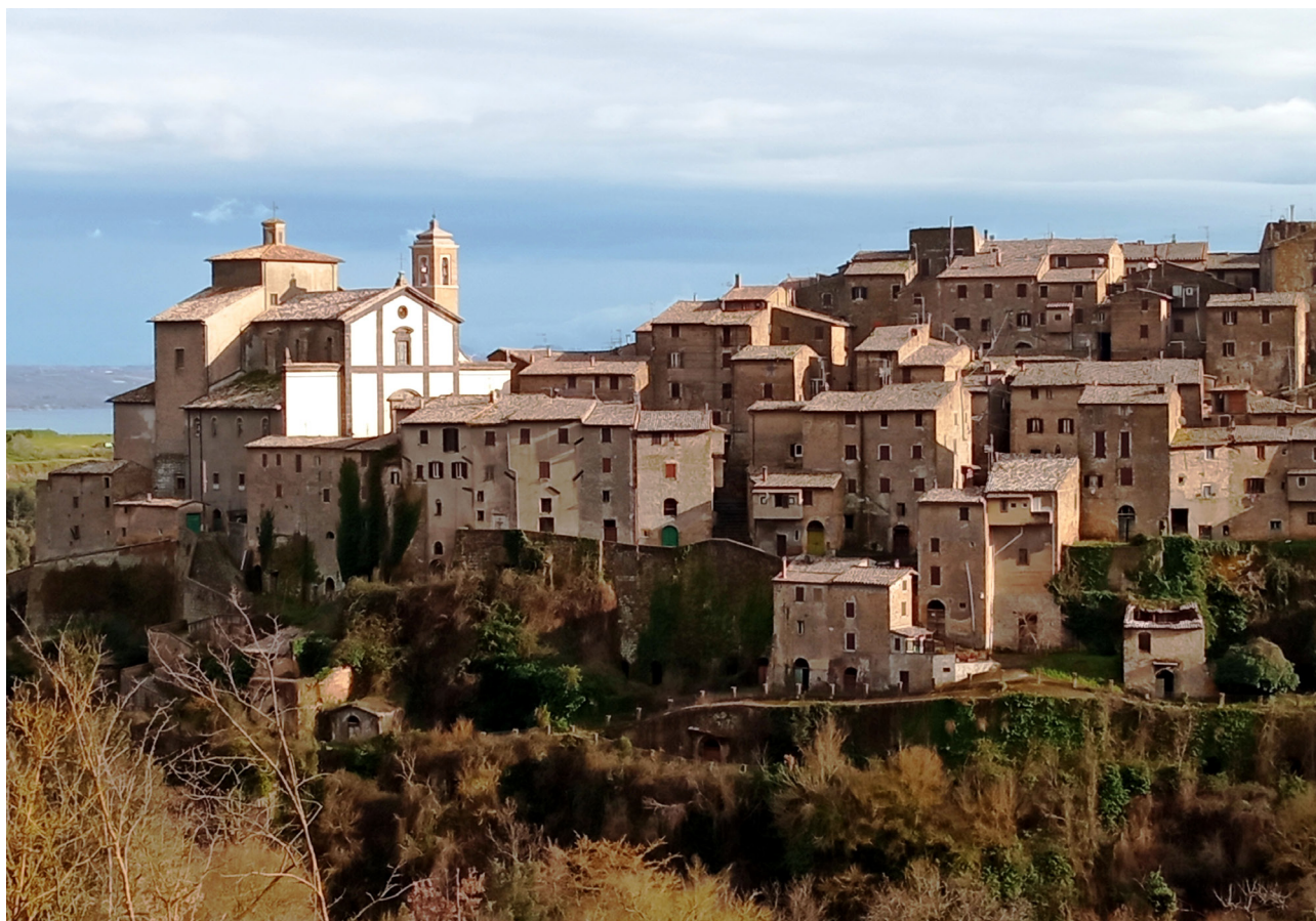
Fig. 2: La bianca facciata della basilica di Santa Maria del Suffragio al vertice sperone tufaceo su cui si erge Grotte di Castro.
