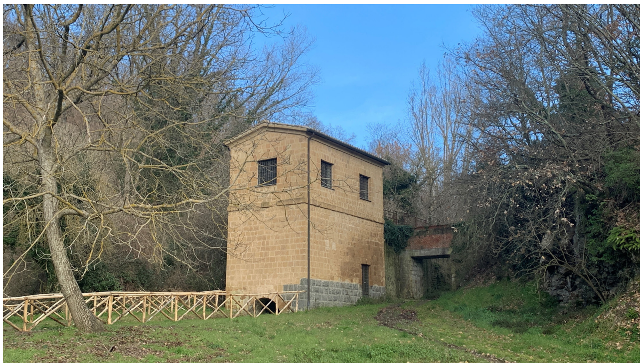
Fig. 5: Edificio ottocentesco delle pompe idrauliche (foto C. Carocci).
