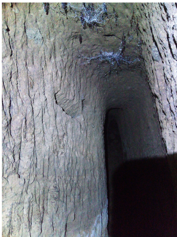
Fig. 8: Incavo con base di appoggio sulla parete ovest del condotto.
