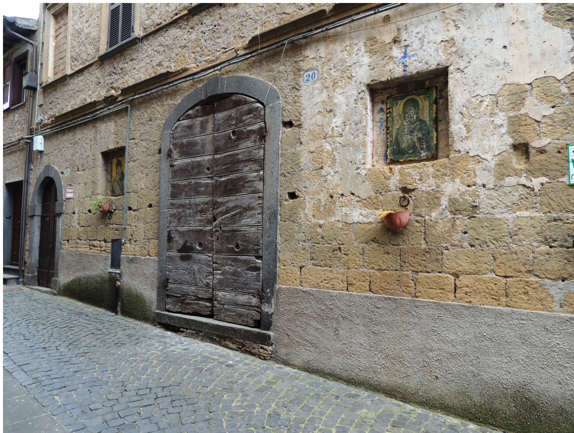
Fig. 6: Edificio che nel passato aveva avuto una funzione pubblica, in cui sono evidenti i conci di forma regolare messi in opera con sottili letti di malta.
