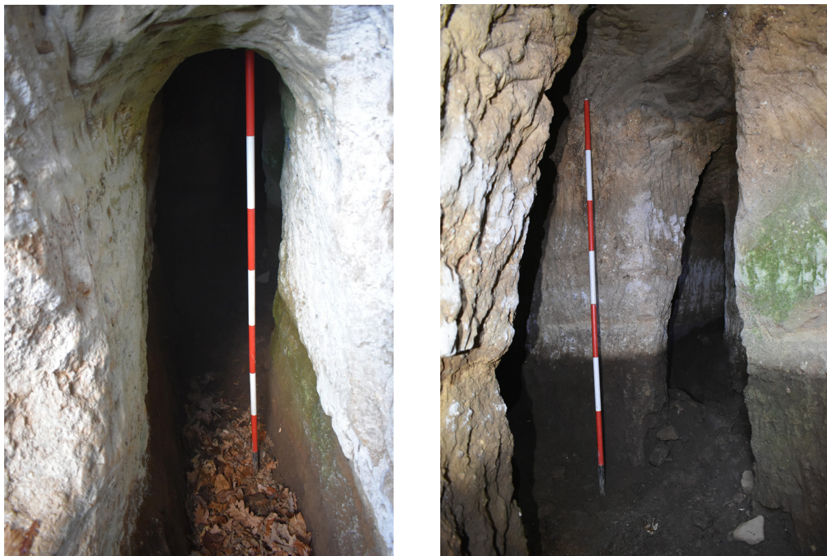
Fig. 3, 4: Tratto principale del condotto e prima deviazione (B) in direzione est.
