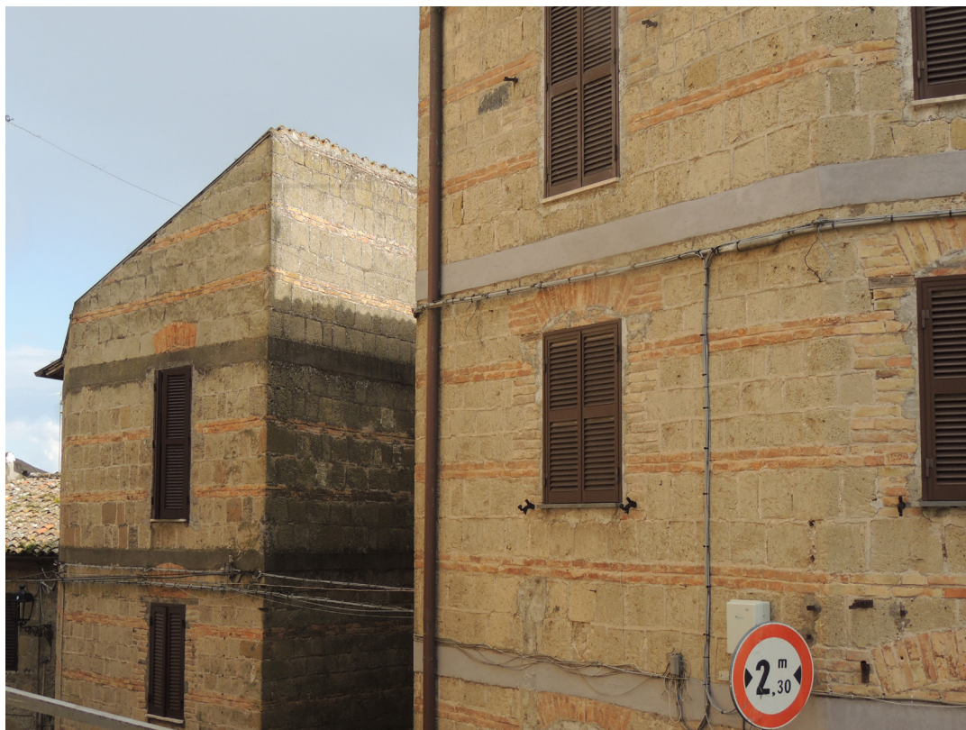
Fig. 8: Edifici ricostruiti dopo il terremoto del 1922. Si notano i solai in cemento armato e la muratura in cui ogni tre corsi in conci di tufo squadrate si alternano due corsi di laterizio.
