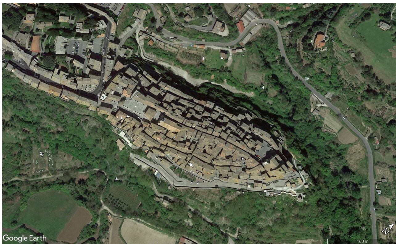
Fig. 3: Il borgo antico di Grotte di Castro in cui è evidente la struttura urbana definita da tre assi viari (immagine da Google Earth).
