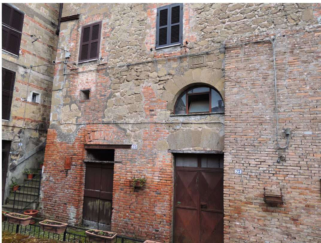
Fig. 9: Realizzazione di contrafforti in laterizio per gli interventi di consolidamento post-terremoto del 1922.
