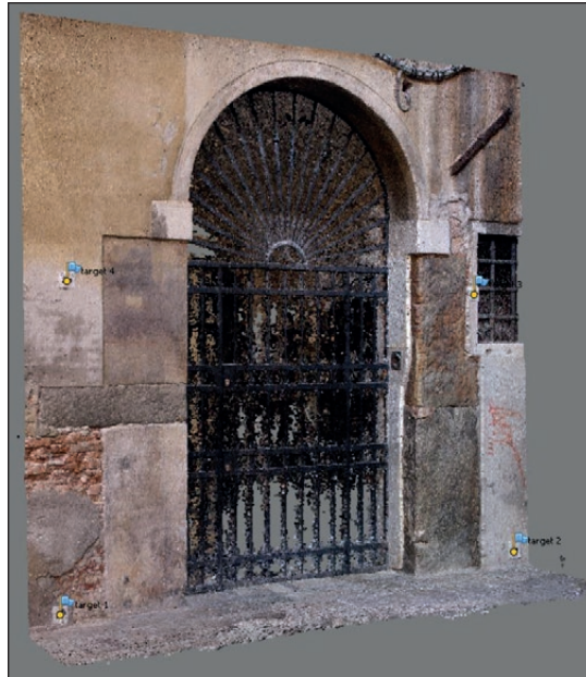
Fig. 6 – Nuvola di punti densa del portale in Corte dei Pali già Testori, Cannaregio 3837, Venezia, e target acquisiti tramite Leica Disto S910 (E. Delpozso).
