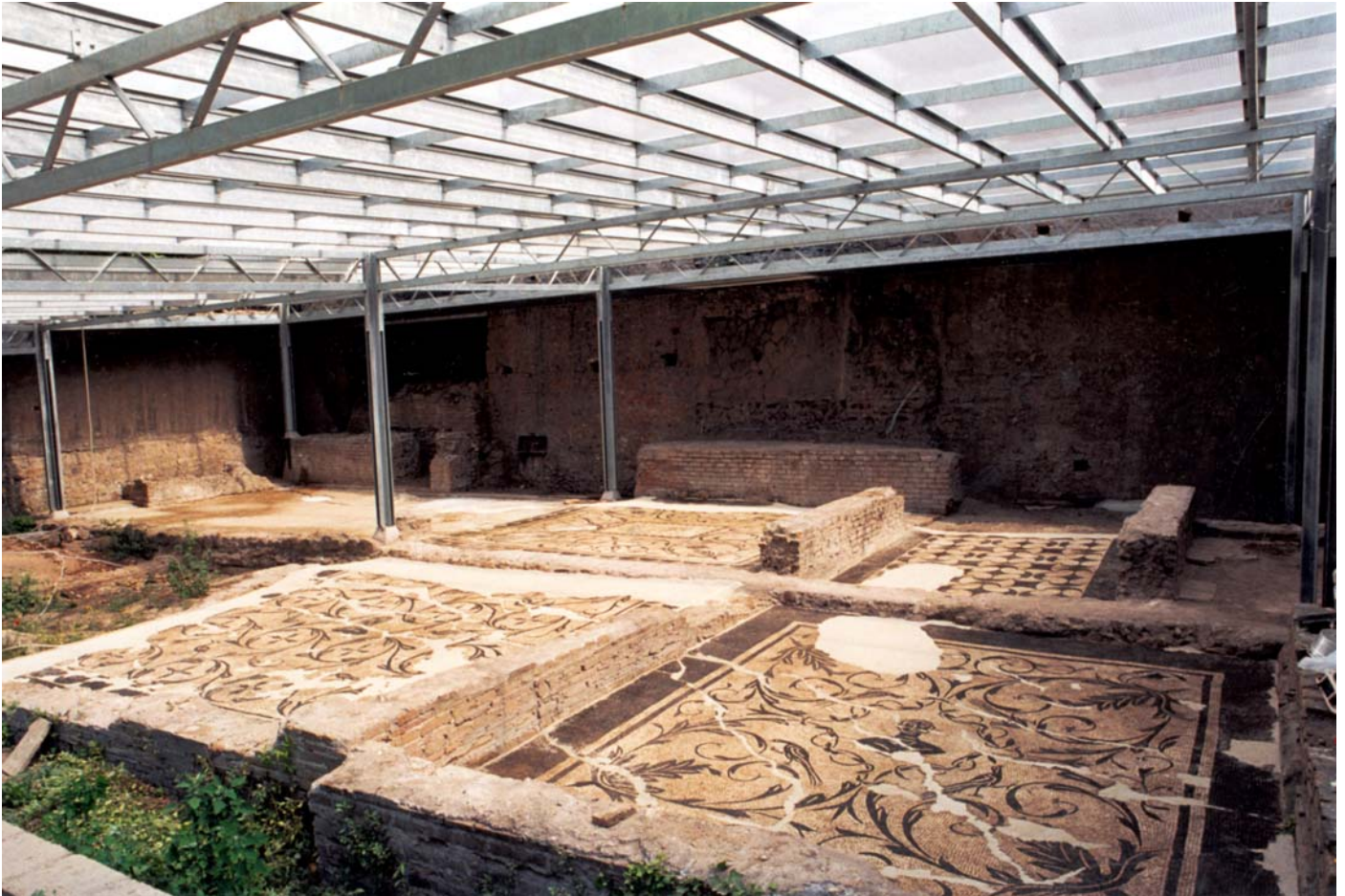
Fig. 3. S. Croce in Gerusalemme. Resti di domus costantiniane con mosaici pavimentali protetti da una nuova copertura.
