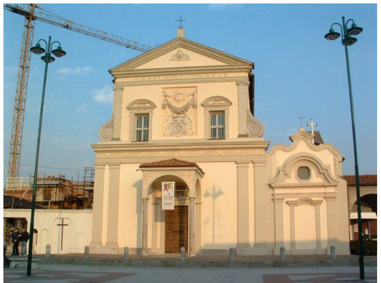
Fig. 1. L'attuale facciata della chiesa.
