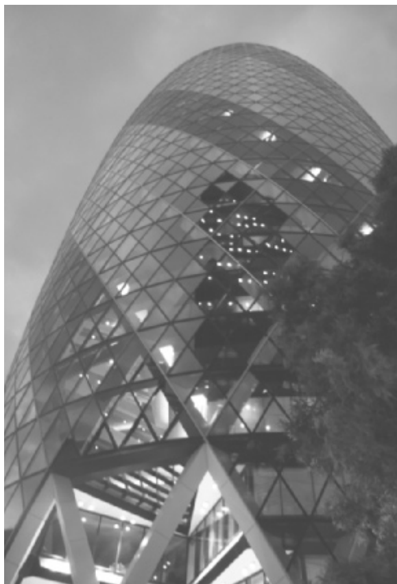
Fig. 1 - Londra, edificio progettato dall'arch. Norman Foster, Swiss Re Tower
