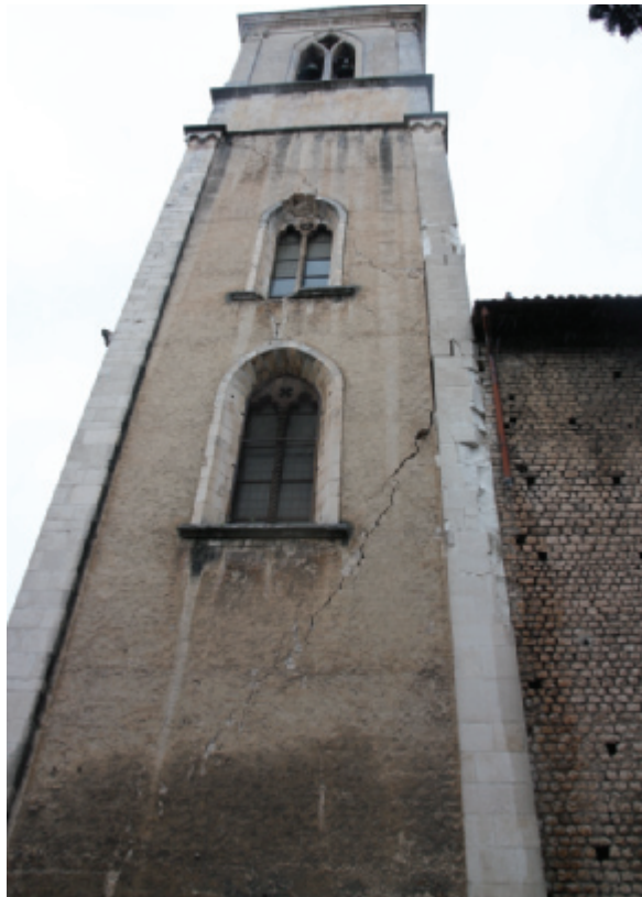
Figura 2.7 - Vista lato est
