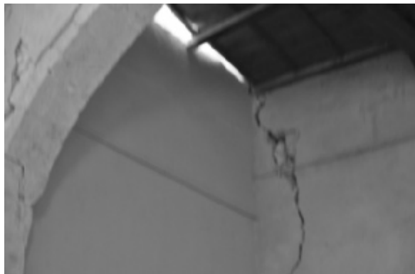
Figura 4.2 - Lesione di distacco della facciata. Si noti la presenza di una catena (quella di fig. 4.4) che ha trattenuto il movimento
