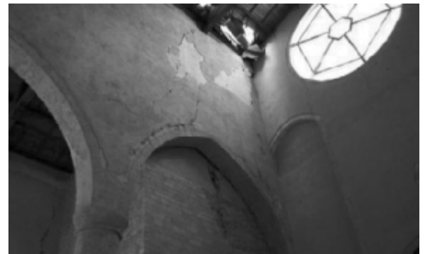
Figura 5.16 - Parete longitudinale lato destro
