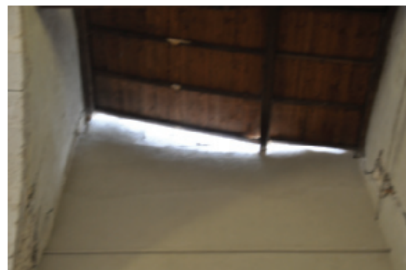
Figg. 5.7 (sopra) e 5.8 (sotto) - Distacco della facciata per ribaltamento verso l'esterno dovuto alle azioni sismiche ortogonali al piano ( meccanismo di primo modo ). È evidente il distacco della copertura e lo sfilamento dell'orditura principale.
