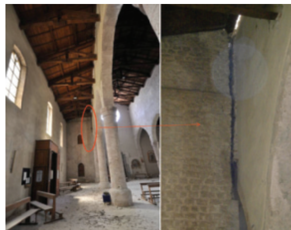
Figura 5.24 - Distacco tra campanile e parete longitudinale (in origine accostati)
