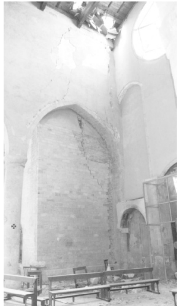
Figura 5.15 - Lesione sulla parete interna del campanile
