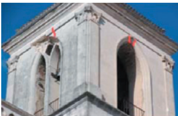
Figg 5.4 (sopra) e Figura 5.5 (sotto) - Le due lesioni pressoché parallele tra loro, associate a quella della bifora nella foto in basso (di direzione concorde) nonché al dissesto di tutti i conci di chiave delle aperture, inducono ad ipotizzare una sollecitazione torsionale sul campanile, indotta anche dalla presenza del piano irrigidente della facciata in posizione fortemente eccentrica. L'espulsione di materiale, evidente nella foto, potrebbe essere dovuta al martellamento della struttura di sostegno delle campane.
