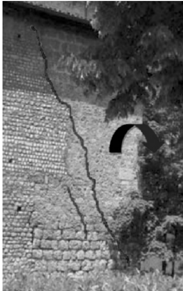
Figg. 5.11 (sopra) e 5.12 (sotto) - Distacco del cuneo nella zona absidale.
