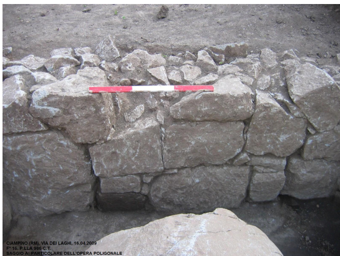
Fig. 9. Saggio A. Particolare dell'opera poligonale del muro di terrazzamento.
