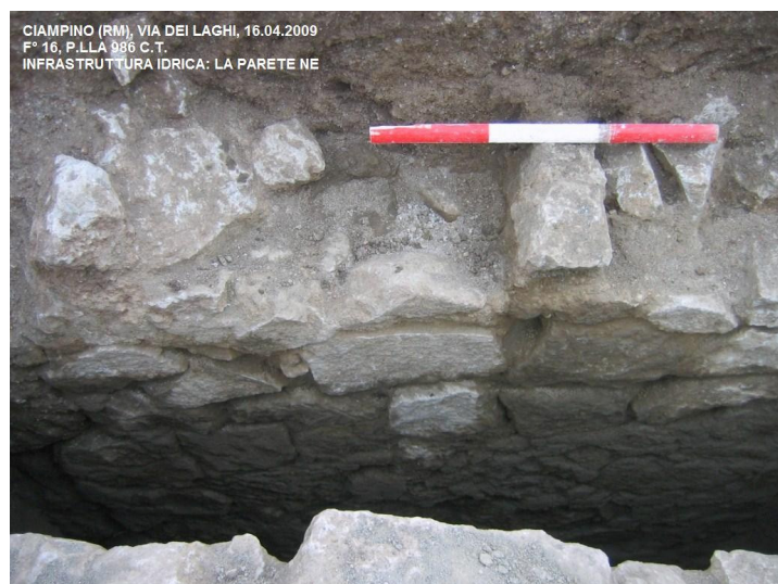
Fig. 25. Invaso dell'infrastruttura idrica. La parete Nord-Est.
