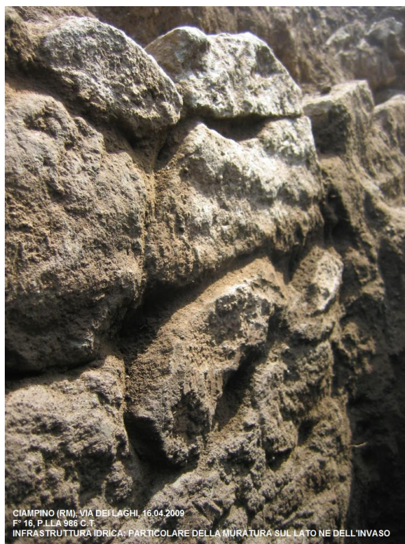
Fig. 26. Invaso dell'infrastruttura idrica. Particolare della muratura in opera poligonale sul lato Nord-Est.
