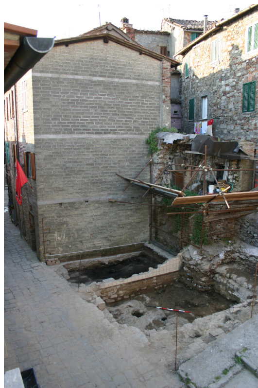
Fig.2. Vista generale dell'edificio de "Le Fonderie" con in primo piano l'area 1000.
