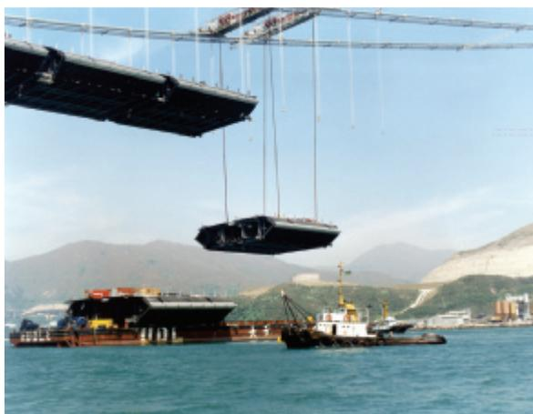
Fig. 4 - Sollevamento dei conci tramite pendini collegati alla trave mobile di sollevamento che scorre sui cavi principali
