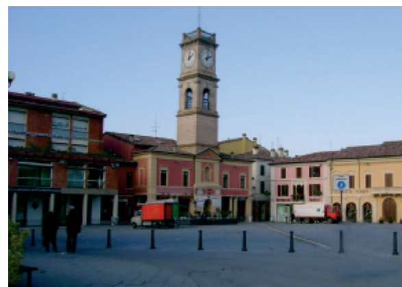
Fig. 1a e 1b - Viste del Palazzo della torre, dalla corte interna della rocca trecentesca antistante e dalla via Emilia.
