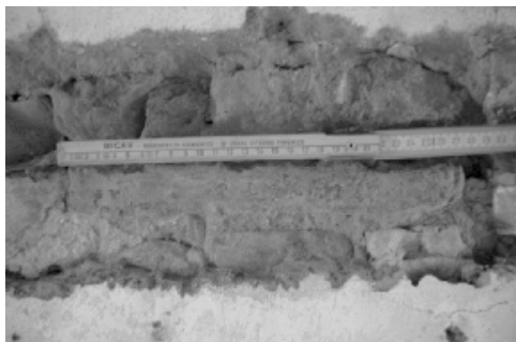
Fig. 2b - Elementi resistenti delle murature del piano terra. Le dimensioni di 28x14x4,6cm sono quelle utilizzate su tutto il territorio romagnolo, dal Basso Medioevo fino all'unità d'Italia.
