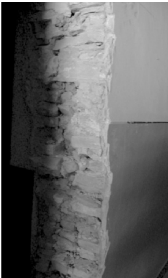
Fig. 2d - Murature miste disordinate al secondo livello.
