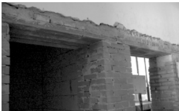
Fig. 2c - Murature di epoca fascista del piano primo.
