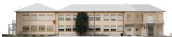
Fig. 5 - Prospetto lato Sud della scuola: a destra il refettorio, a sinistra le aule e l'ingresso.
