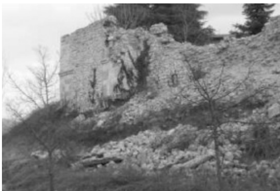
Le mura urbane dopo il terremoto dell'aprile 2009.
