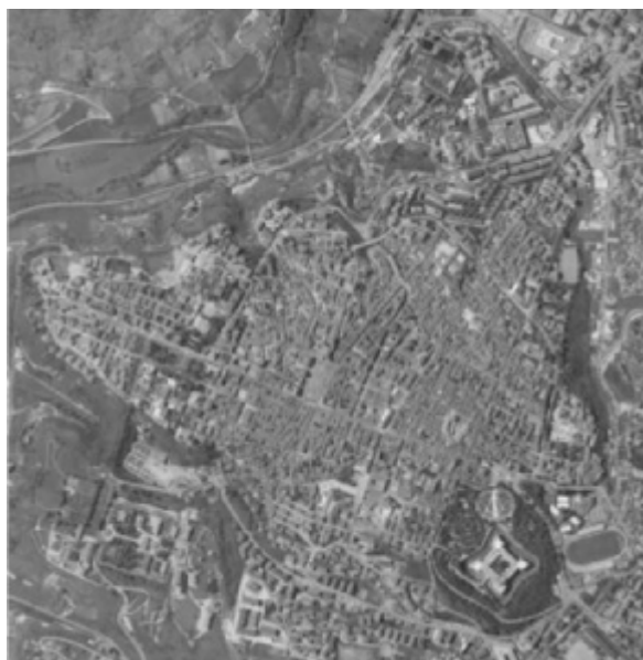
L'Aquila, il centro storico dopo il sisma del 6 aprile 2009.
