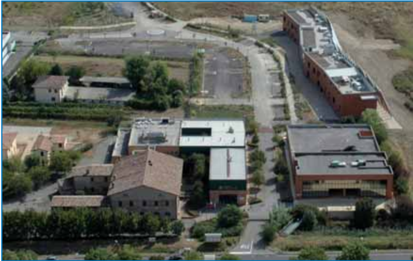
Fig. 11: Veduta aerea dell'area che comprende l'edificio dell'ISTEK ( a sinistra), l'edificio dell'Agencia Polo Cearnico (a destra) e, sul retro, i locali dell'incubatore. Le strutture costituiscono il nucleo centrale del progetto Parco delle Arti e delle Scienze Torricelli.
