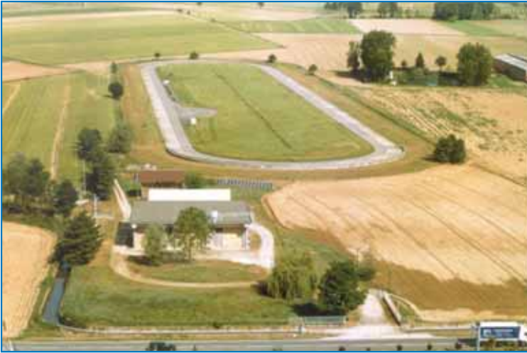
Fig. 7: Vista aere delle piste di prova e dei laboratori IMAMOTER presso Candiolo (TO)
