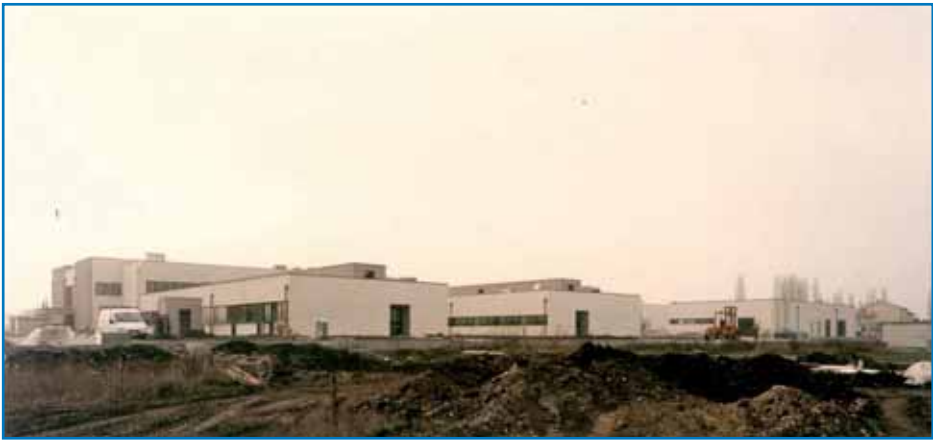
Fig. 13A: L'attuale edificio IMEM, durante l'edificazione
