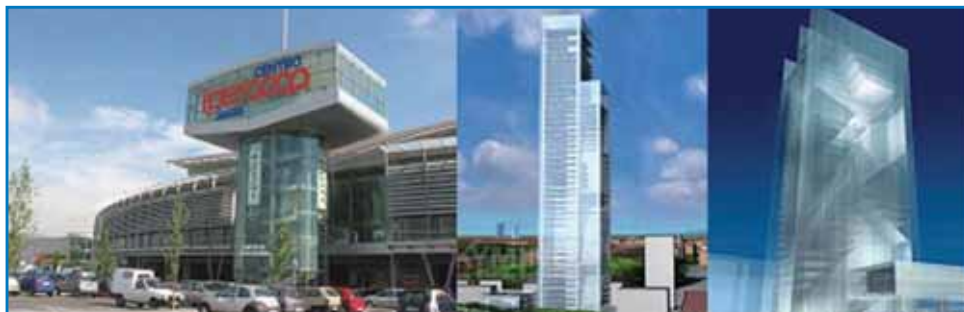
Figura 3. Esempi di edifici certificati o in corso di certificazione con il Protocollo SBTool IT
