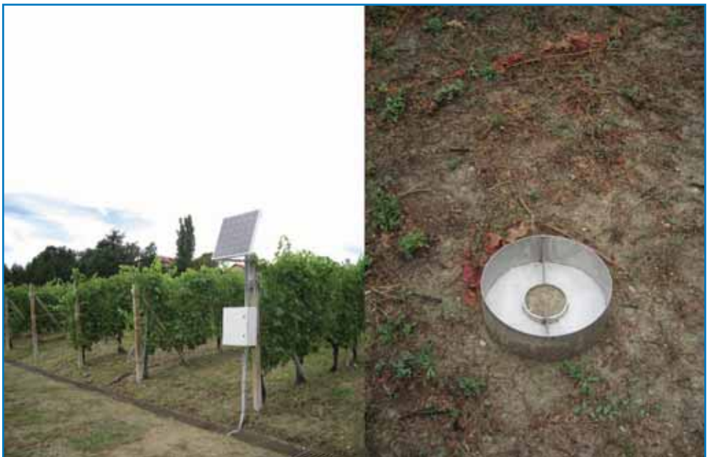
Fig. 21: Centralina e pannello fotovoltaico per l'alimentazione del sistema di automazione delle misure di deflusso (a) e splash cup posizionata in una delle parcelle sperimentali a rittochino (b)
