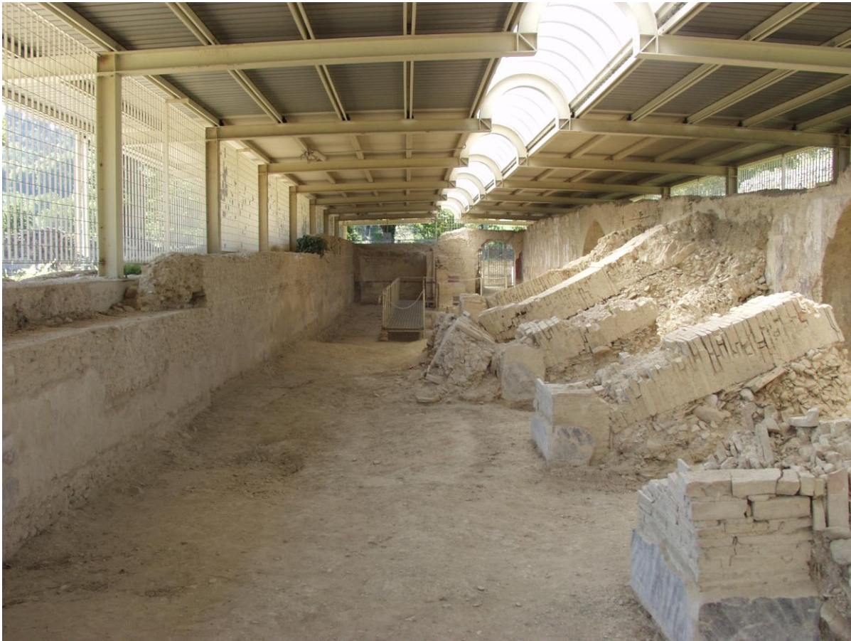
Fig. 20. Urbs Salvia : galleria meridionale del Criptoportico. La galleria meridionale del Criptoportico dopo le operazioni di rimozione di parte dei crolli. Da Est.
