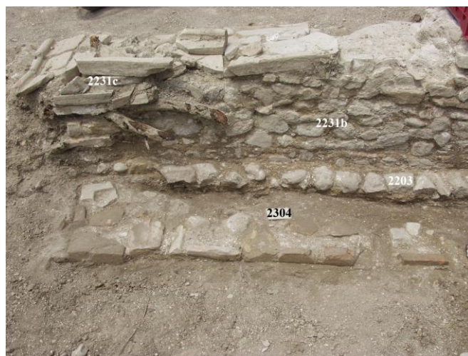
Fig. 5. Urbs Salvia: area del Tempio-Criptoportico. Risega di fondazione ( 2203 ) dei tratti murari 2231b e 2231c e resti probabili ( 2304 ) del marciapiede occidentale del Portico. Da Est.
