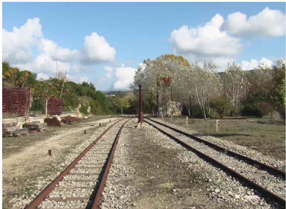
Tratto della strada ferrata non appartenente all'area di progetto e che mostra i binari ancora esistenti nei pressi della stazione di Sarcidano.
