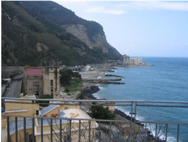
Foto 2 – Area ex-cementificio trasformata in struttura alberghiera e balneare sul litorale stabiese.
