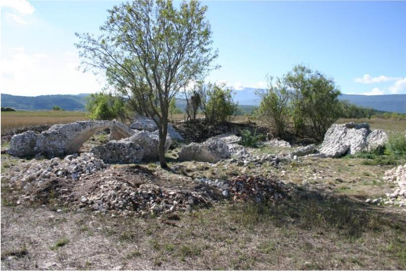
Fig. 9. Cisterna presso la porta occidentale; stato delle volte in crollo primario.
