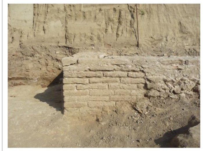
Fig. 6. Particolare delle angolate in opera laterizia sulle murature dell'infrastruttura portuale.
