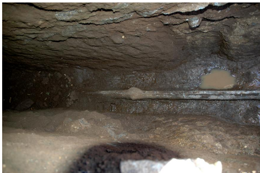
Fig. 33. Vetralla (Vt), Loc. "Pian di S. Martino". Resti di un acquedotto nelle vicinanze dell'antica Via Cassia. Particolare della fistula plumbea.
