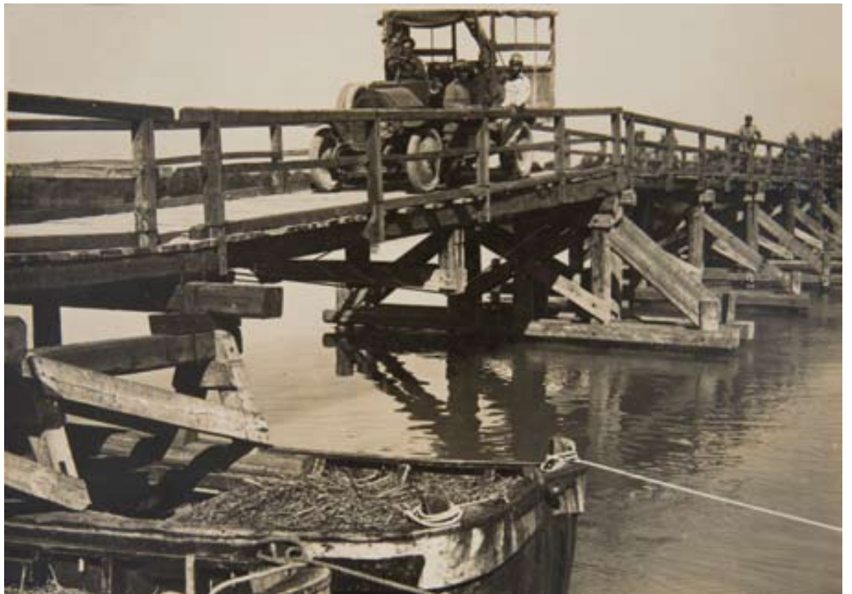
14 -15. Laguna di Venezia. Ponte ligneo su cavalletti e barche, 1918. Ponte di Ca' Nordio sull'Adige (lunghezza 222,50 metri; oscillazione prevista tra metri 1,30 sopra la guardia e metri 1,70 sotto la guardia dell'idrometro di Cavanella d'Adige). Teoria dei cavalletti a piedritti verticali; campata mobile di sinistra.
