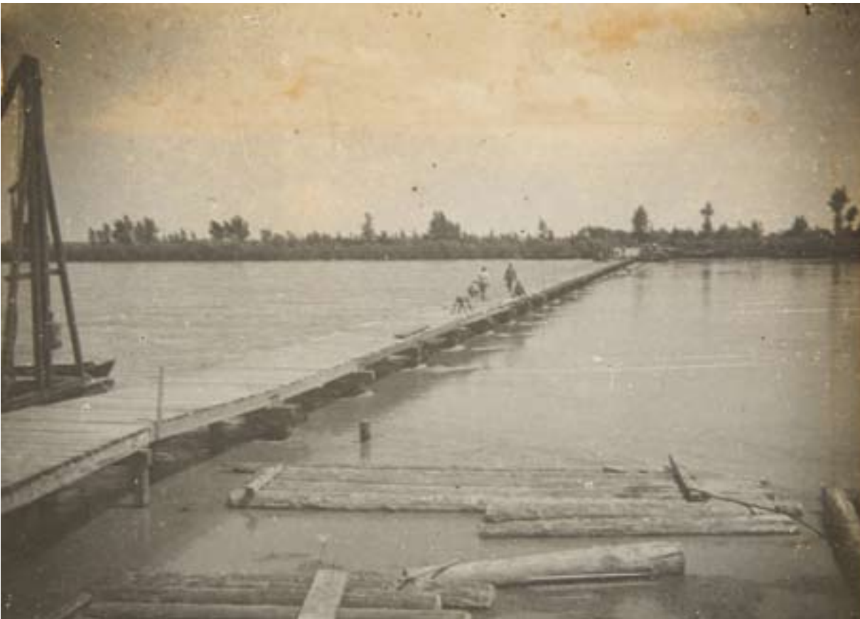
16 - 17. Laguna di Venezia. Ponte ligneo su cavalletti e barche, 1918. Passaggio finale del direttore del genio su una Isotta Fraschini; il ponte in costruzione durante la piena del giugno 1918 (a sinistra il castello del battipalo). Sistemazione difensiva , 1918. Collezione privata.
