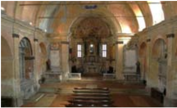
37 Navata della chiesa, fotografia dello stato di fatto.
