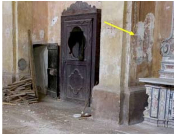
9 Particolare del lato dipinto, pilastro di sostegn dell'ordine inferiore della navata.
