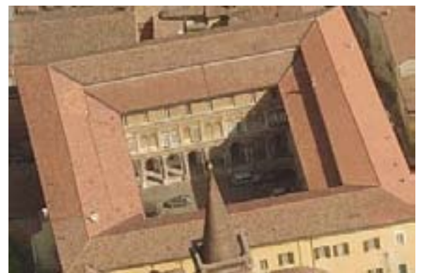
14 Chiostro di San Pietro al Po, Cremona, vista aerea.
