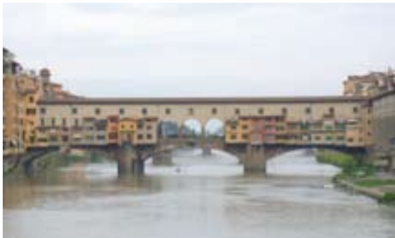
Fig.1 - Ponte Vecchio a Firenze
