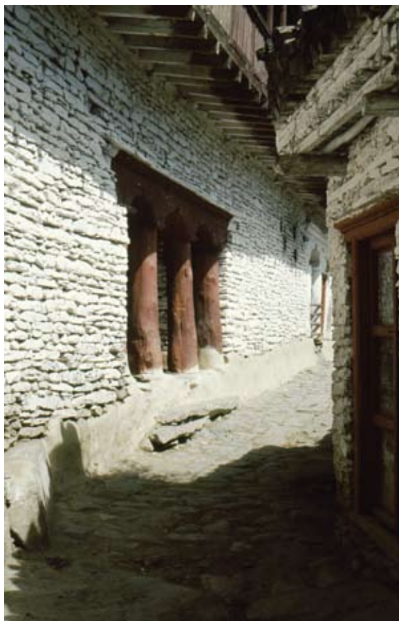
3 - Muratura in una costruzione thakali nella Kali Gandaki (Nepal)
