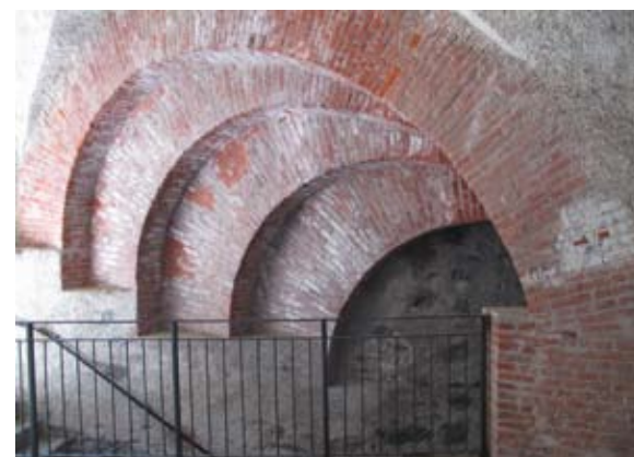
16-17. Fenestrelle. Fortezza. Volta a botte e arcate laterali
