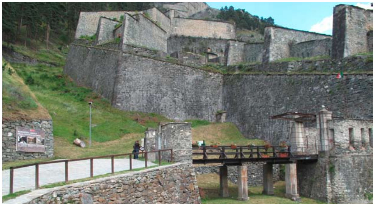
7-8. Fortezza di Fenestrelle. Fronte rinforzato principale verso Fenestrelle, con la visuale difensiva del secondo fianco di sinistra (sopra).
